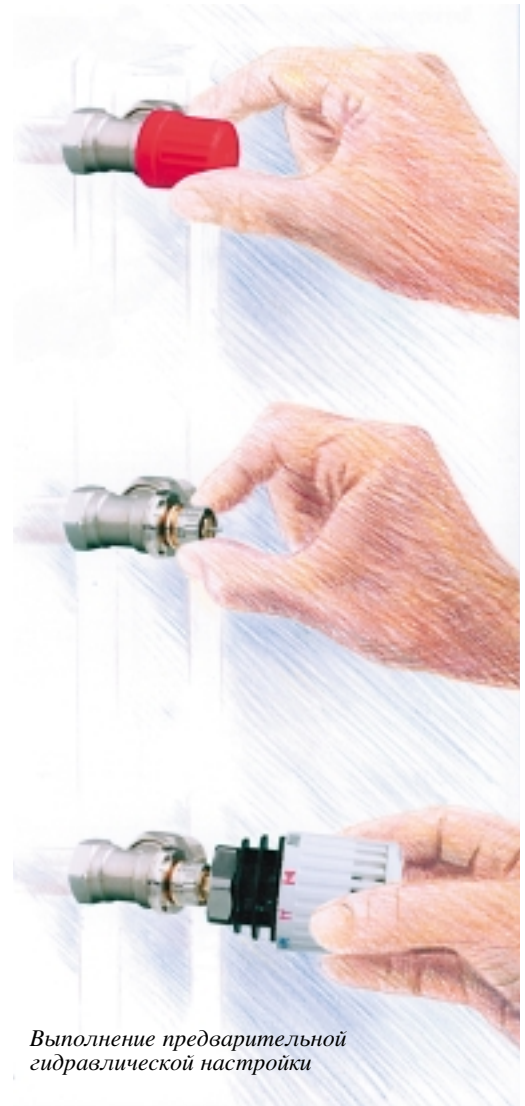
Устройство предварительной настройки клапана RND-N
