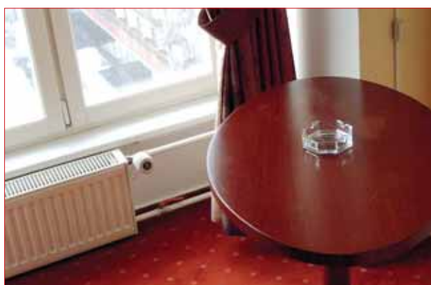
■ Номер в гостинице «Россия». При замене отопительного прибора на новый был сохранен старый терморегулятор «Данфосс»
